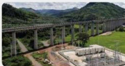
中老铁路供电项目
